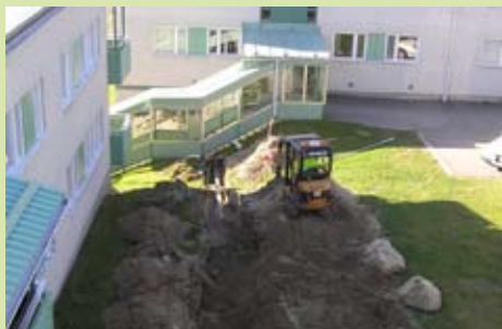
Grävning ny kulvert Tjädern 32
