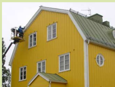
Pågående ommålning Borgaren 2
